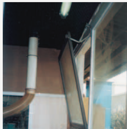
Fig. 19 La prise d'air est réalisée tout simplement en ouvrant une fenêtre directement dans la cabine
